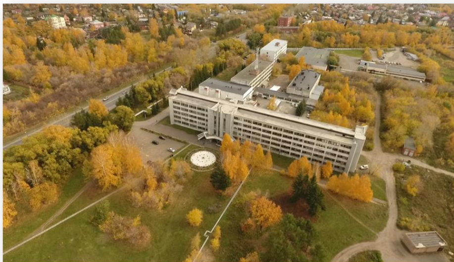
Рисунок 6. Здание селекционного центра.
